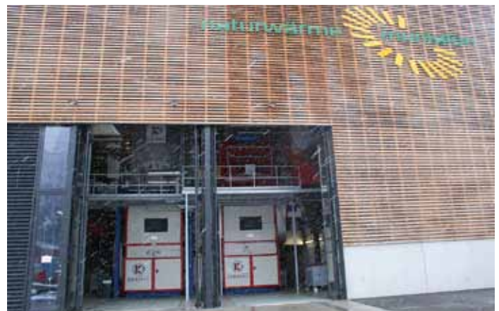
Anlagen-Know-how aus Kärnten bei dem zweitgrößten Biomasseheizkraftwerk in Vorarlberg, es werden 8000 t/J CO 2 in der Region eingespart
