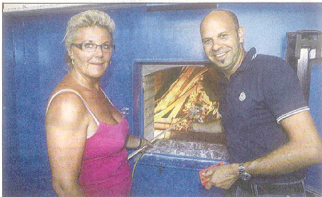
Ofenpatin Erna Both und Geschäftsführer Jürgen Kuster bei der Erstfeuerung der Naturwärme Montafon. (Foto: meznar-media.com)
