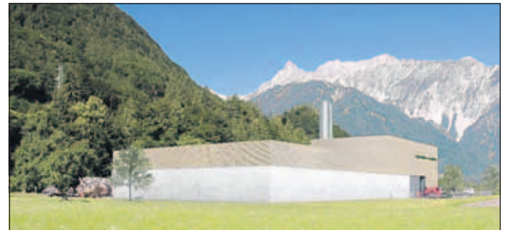
Das Naturwärmekraftwerk Montafon liefert ab Herbst neben Wärme und Ökostrom auch Fernkälte. (Foto: Computeranimation: Architekt Bader)
