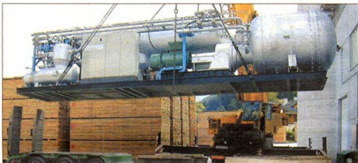
Die Stromerzeugung findet im ORC-Modul statt. Dieses wird fertig installiert geliefert. (Foto: moo)
